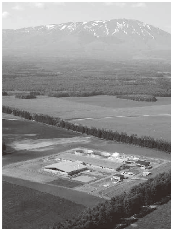
バイオガス発電所
