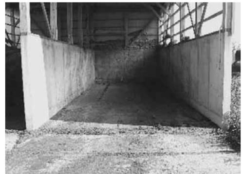
図4. 通風式堆積型堆肥舎
